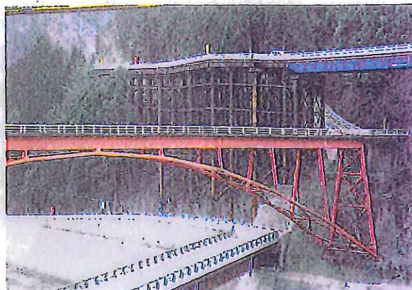
大型観光バスも24時間通行できる国道168号の新しい迂回路——番上。その下はこれまでの迂回路に使用した堂平橋、手前は熊野川
