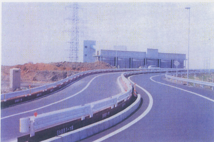
【使用実績例】 仙台東部自動車道仙台港北ICオンランプ：オフランプ (R45～仙台港北IC料金所間道路)
